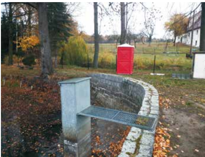
Feuerwehrstellfläche und Löschwassersauganschluss
