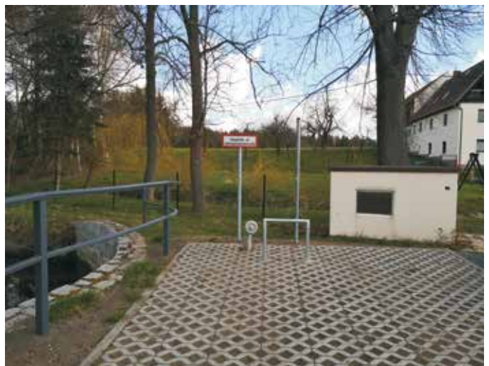
Feuerwehrstellfläche und Löschwassersauganschluss
