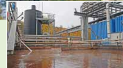
Wasserbehandlungsanlage Schlema-Alberoda: Reaktionsbecken und Strippkolonne
